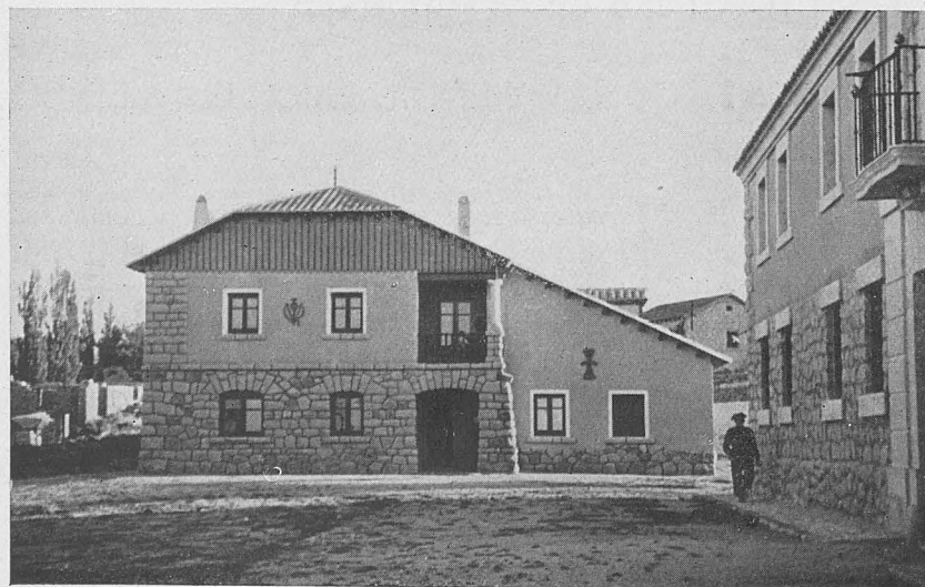
Centro Rural de Higiene de VILLACASTIN (Sego- via).—Fachada principal.
