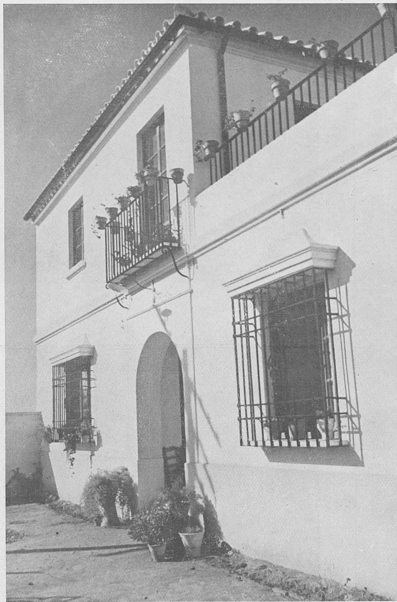
ALCOLEA (Córdoba).—Detalle de la fachada.
