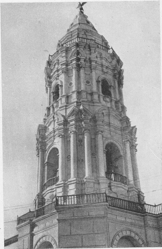
Elegante torre de Santo Domingo.—Fue reconstruida desde la mitad de su primer cuerpo, según los dibujos de restauración del arquitecto peruano D. Emilio Harth-terré, de acuerdo con la primitiva arquitectura que tuvo en 1776.
