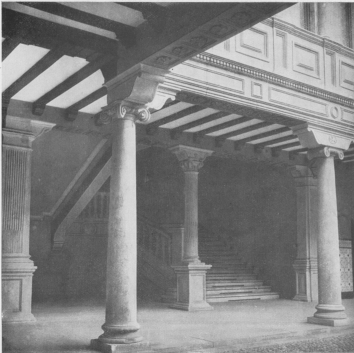
Vestibulo y arranque de la escalera.
