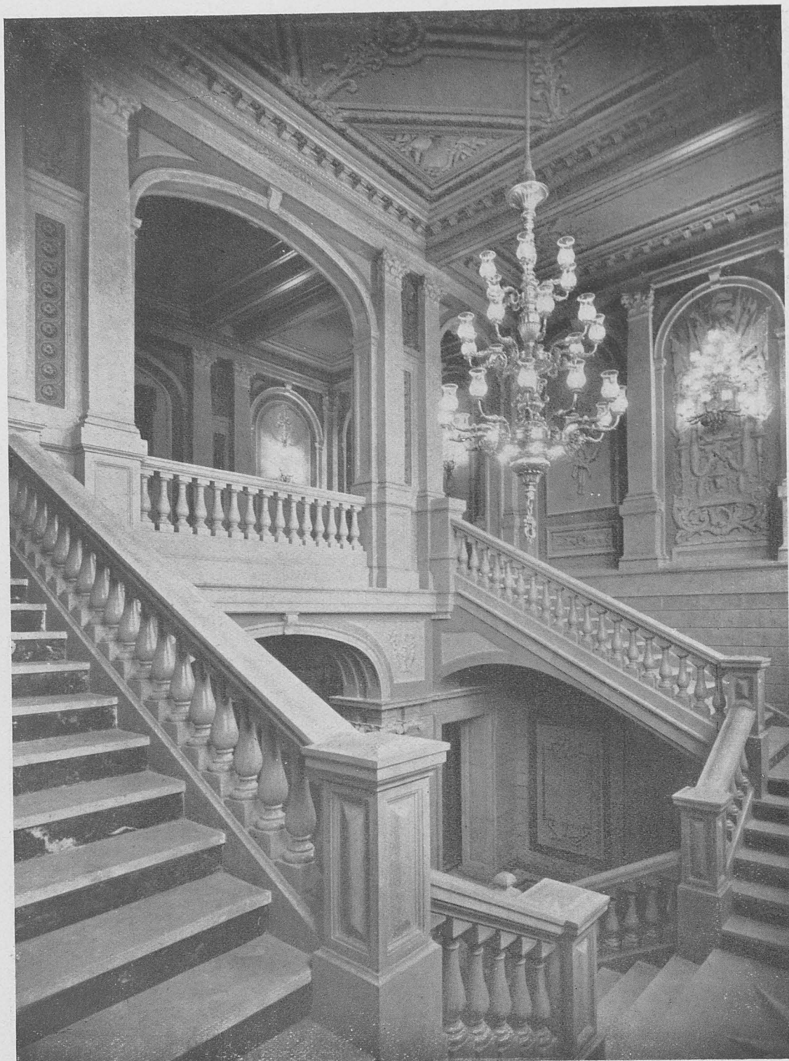
Gobierno Civil.—Detalle de la escalera principal.
