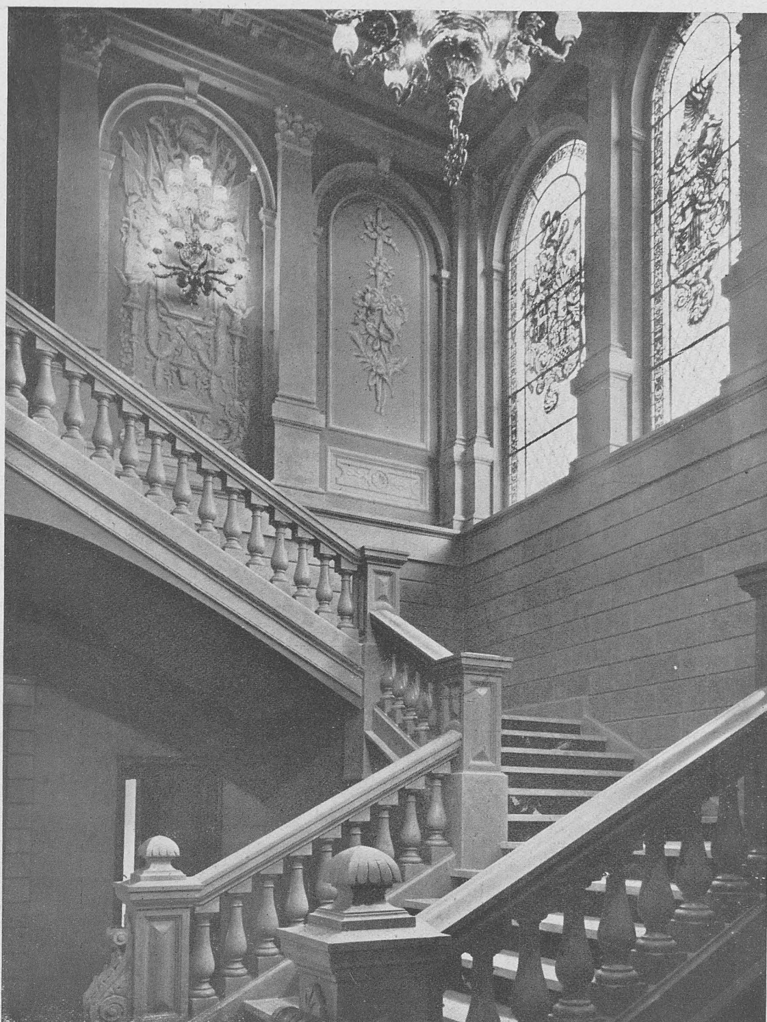
Gobierno Civil.—Detalle de la escalera principal.
