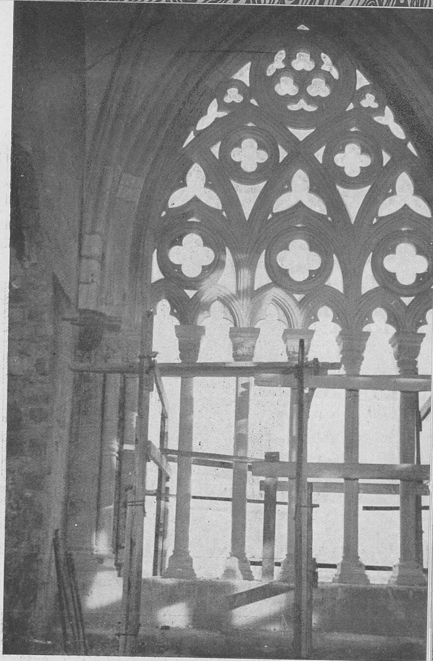
Ventanal totalmente reconstruído.
