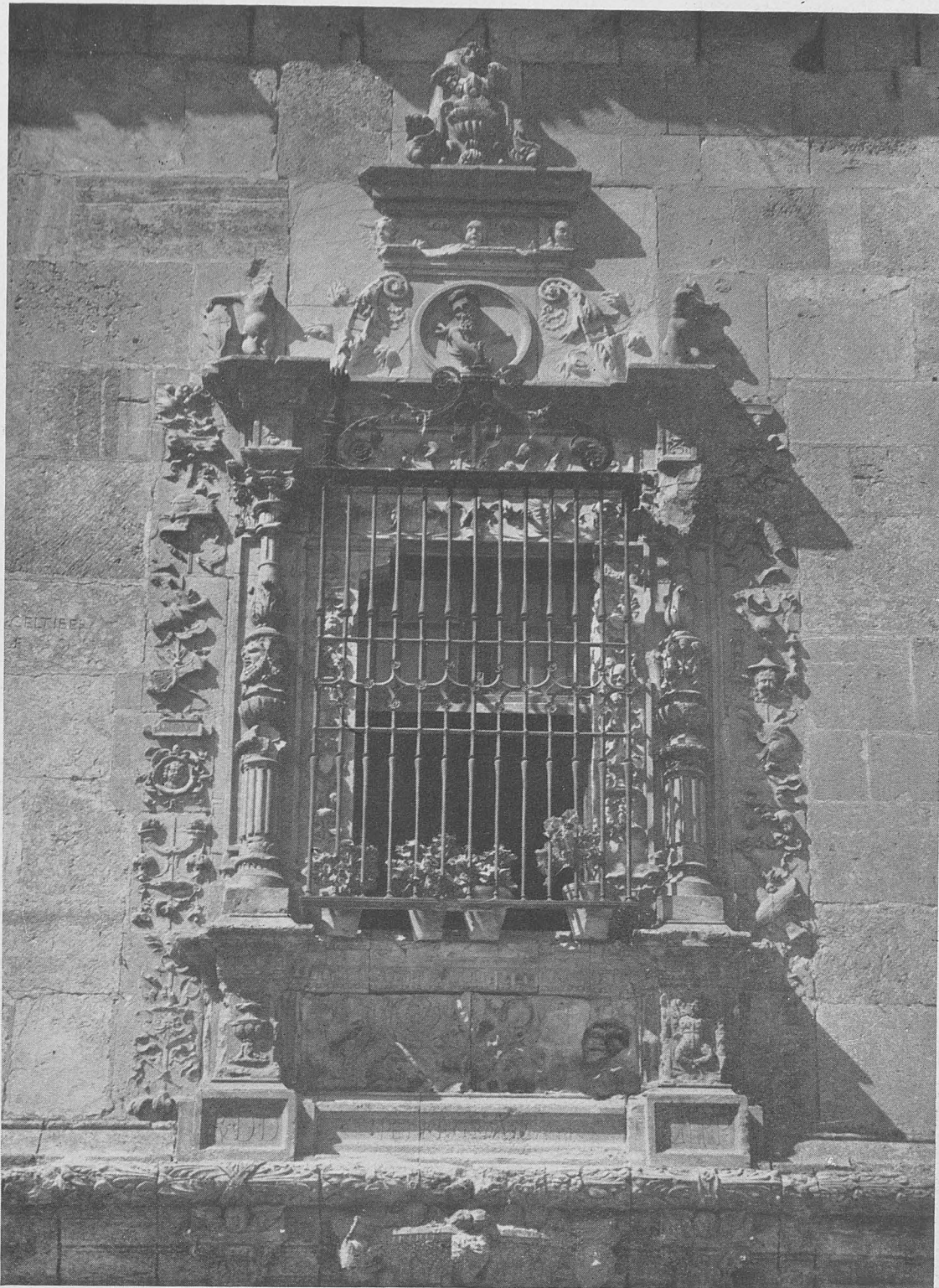
Ventana plateresca de la fachada a saliente.
