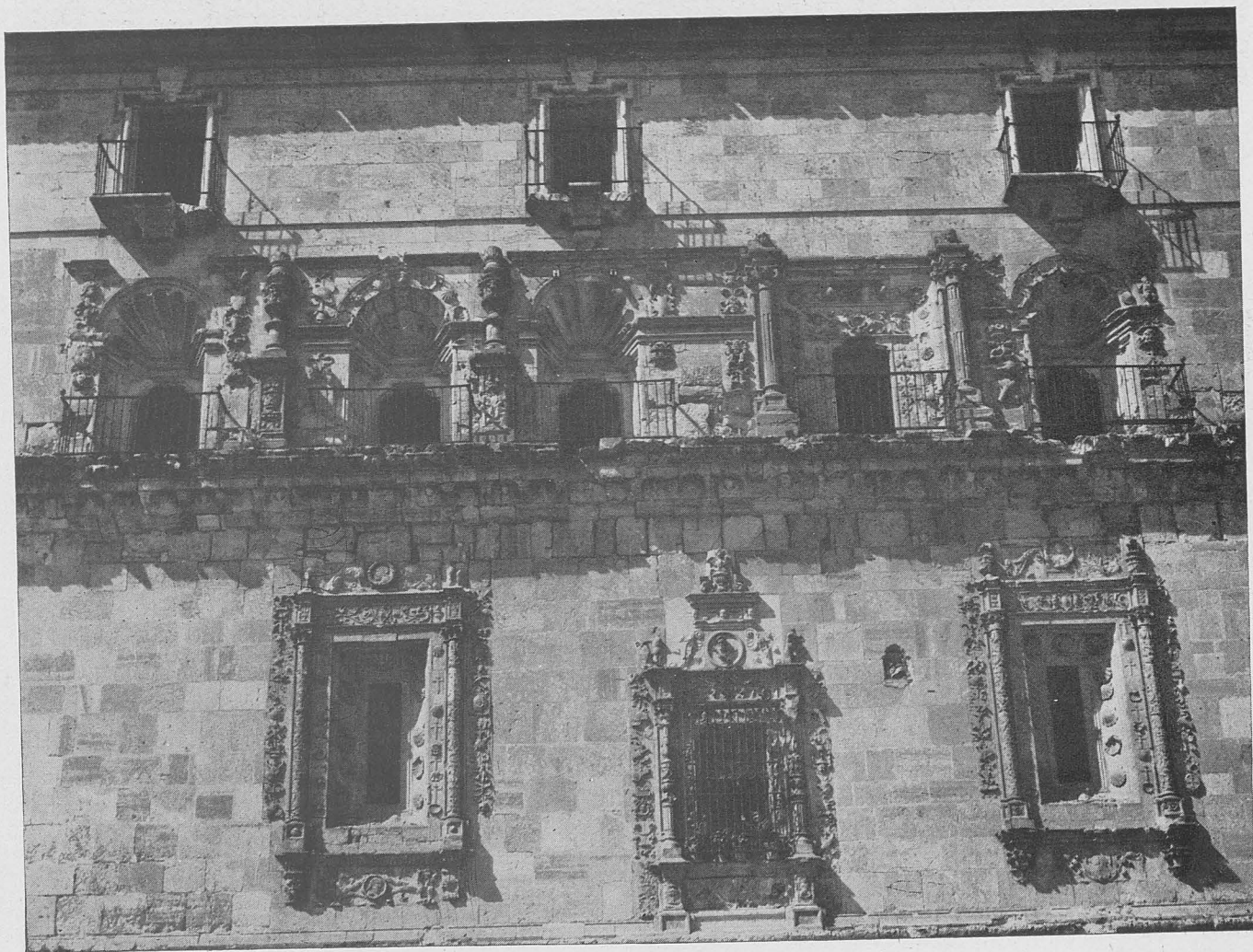
Detalle de la fachada a saliente.
