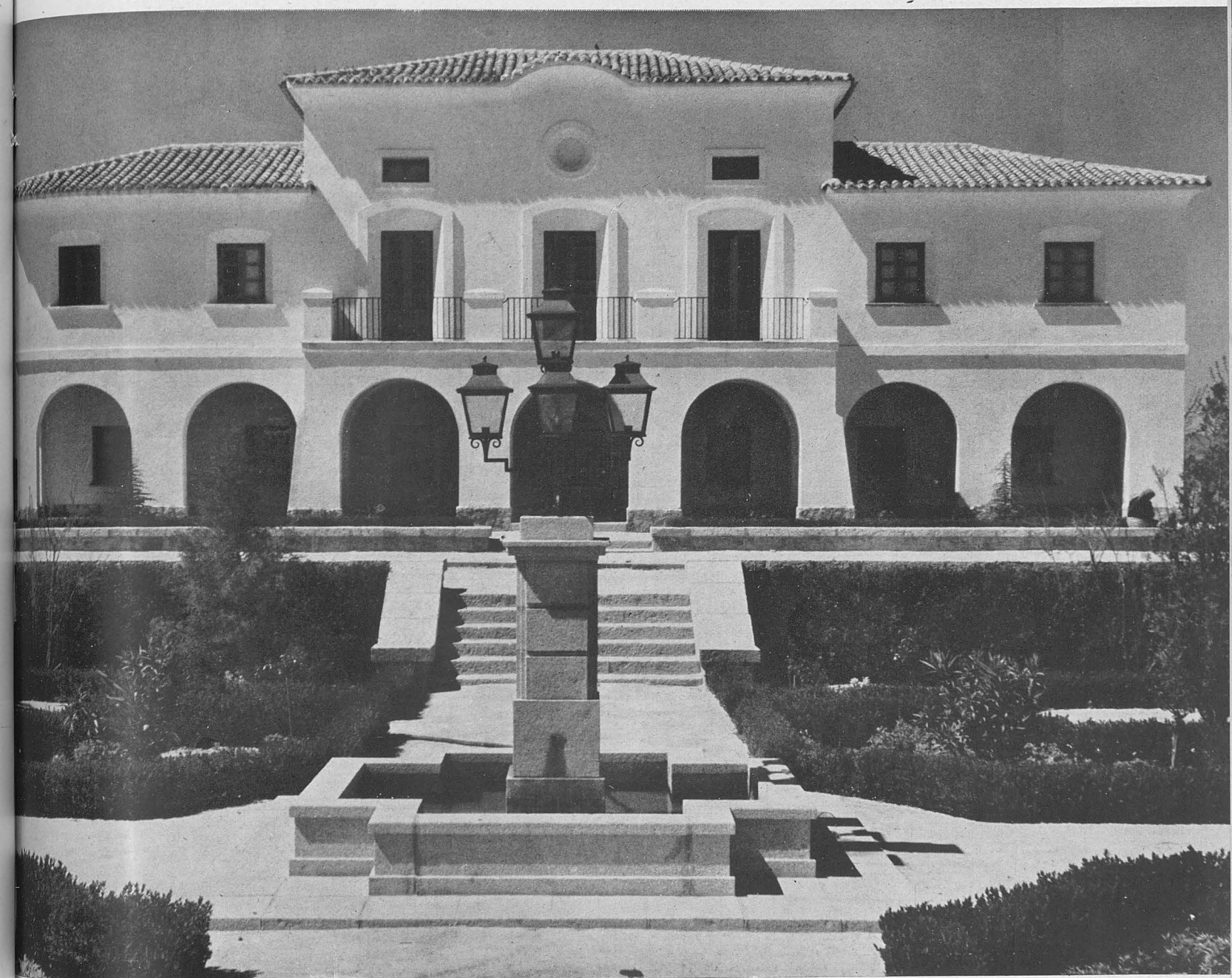
VILLANUEVA DE LA CAÑADA. Ayuntamiento. Fachada principal.
