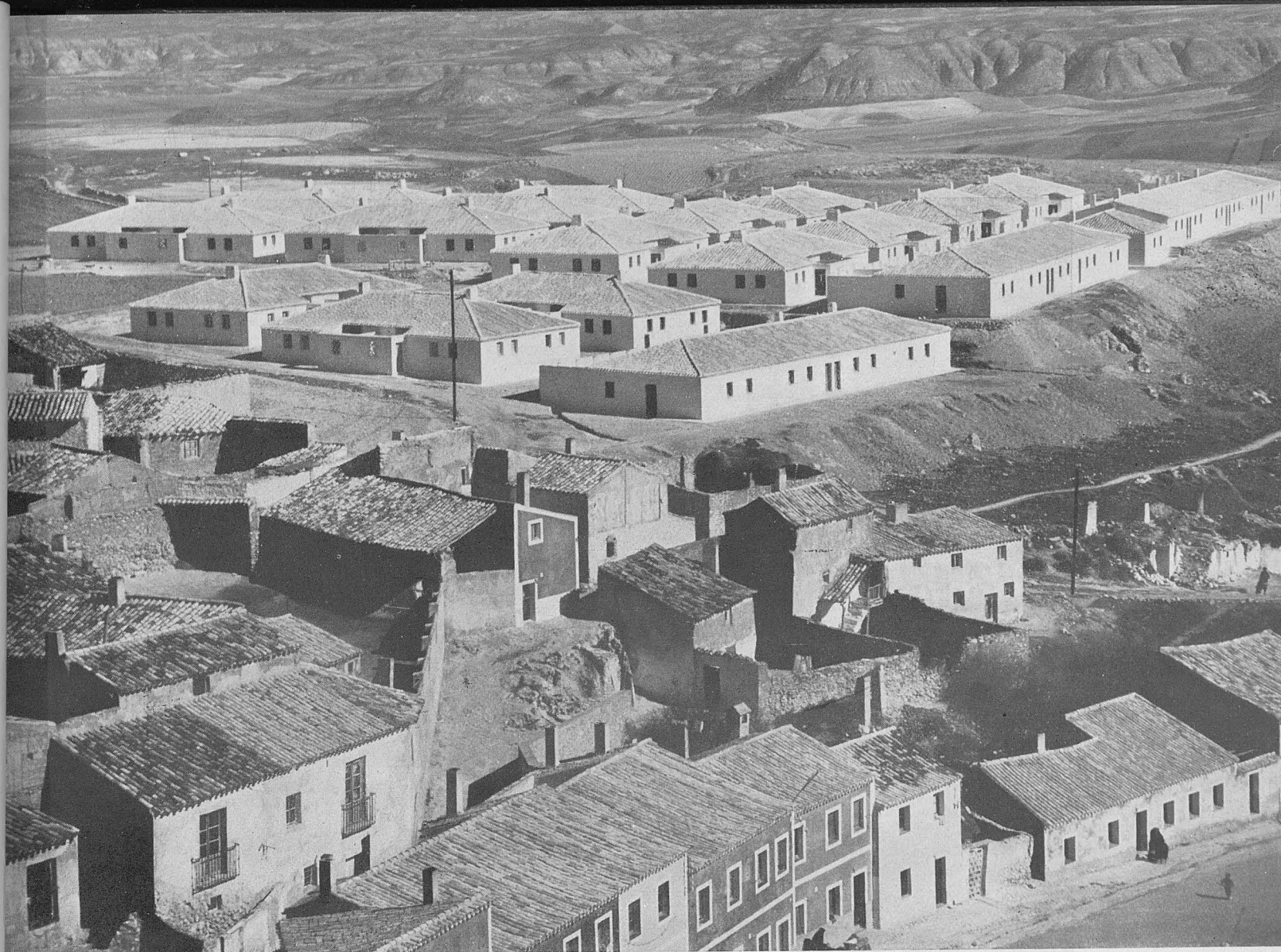
Bloque de 80 viviendas unifamiliares.
