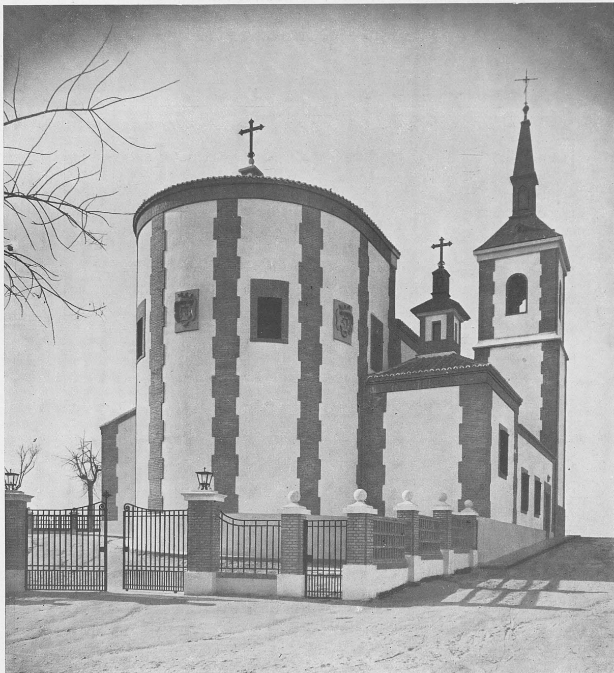
Iglesia de Aravaca. Fachadas lateral y posterior.
