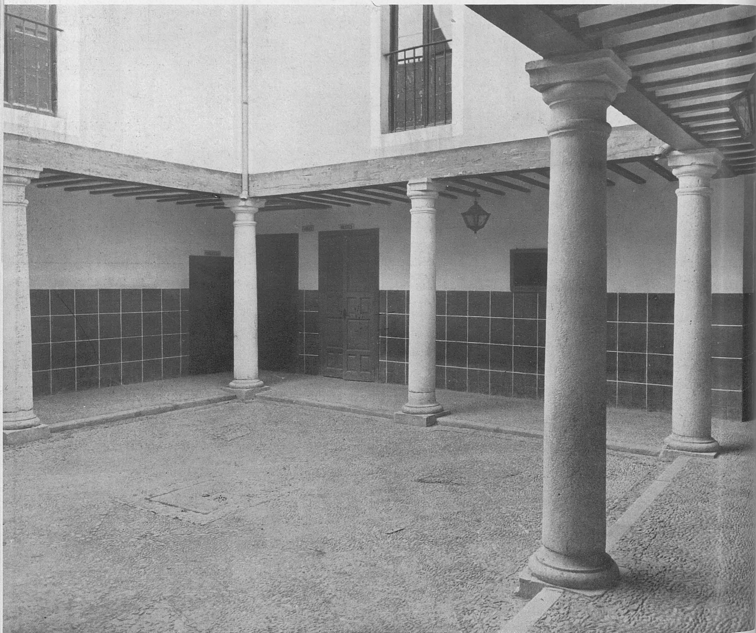
Patio del Palacio de Riánsares, totalmente reconstruido.
