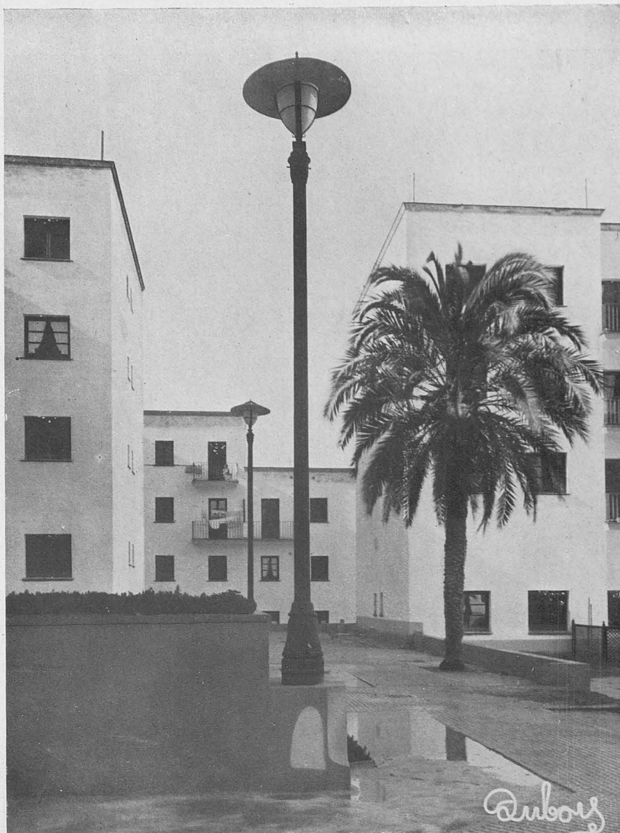
CADIZ.—Bloques de viviendas de San Severiano. Farolas.
