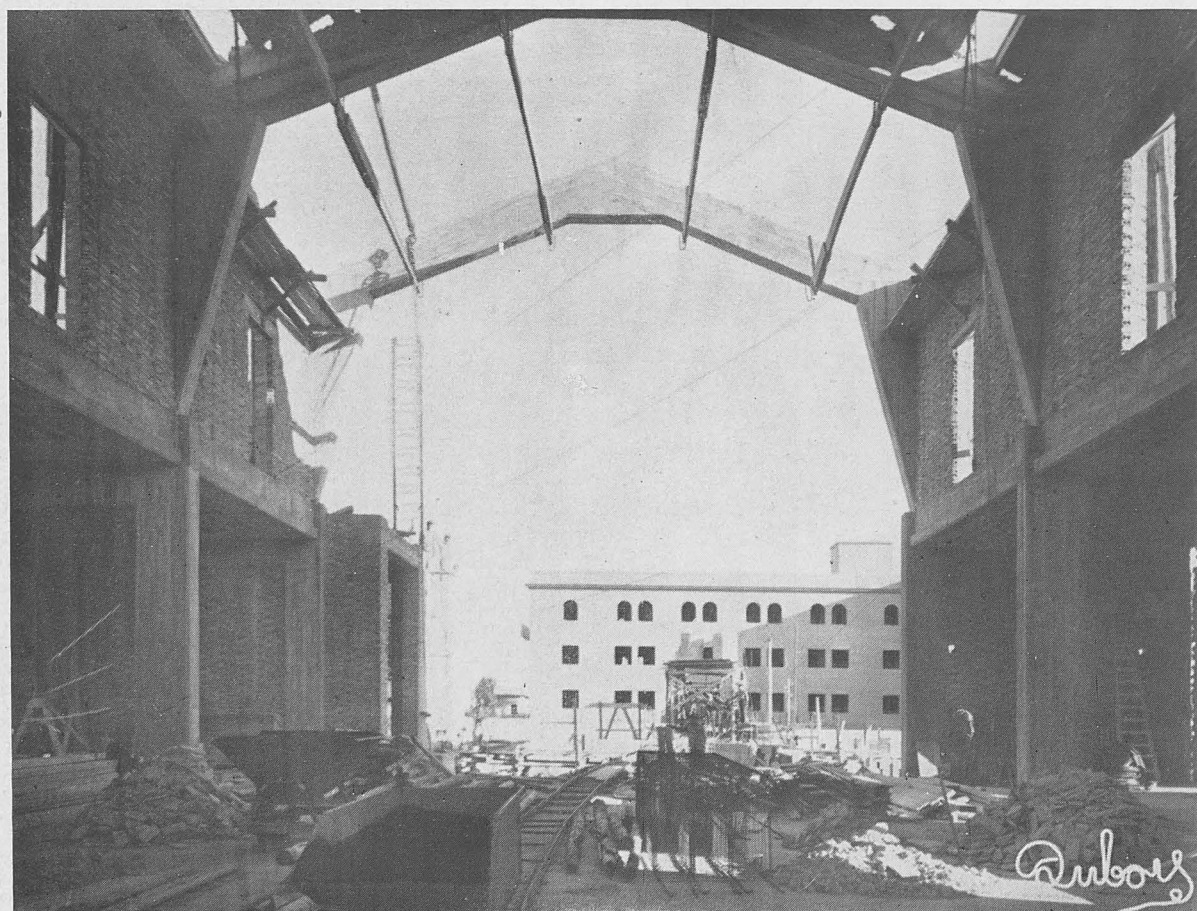
CADIZ.—Iglesia de San Severiano. Las obras en 1952.
