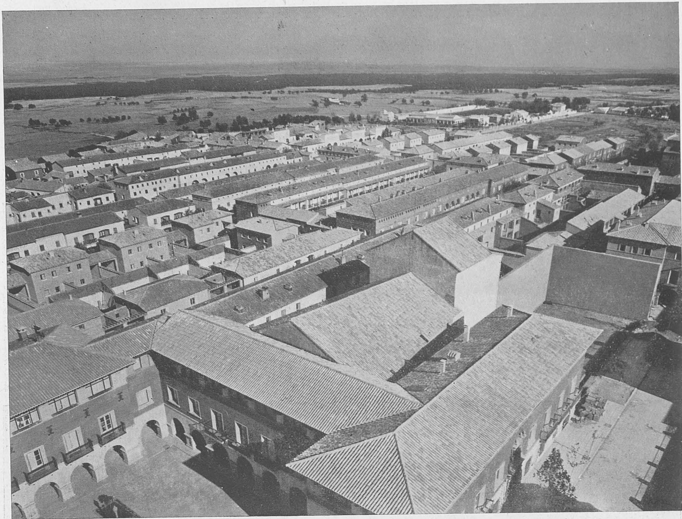
Vista, desde la torre de la iglesia, del edificio para actividades culturales y del Movimiento. Se aprecia, por su forma trapezoidal, la sala de espectáculos; de mayor altura el frontón de pelota, juego de gran tradición aragonesa.
