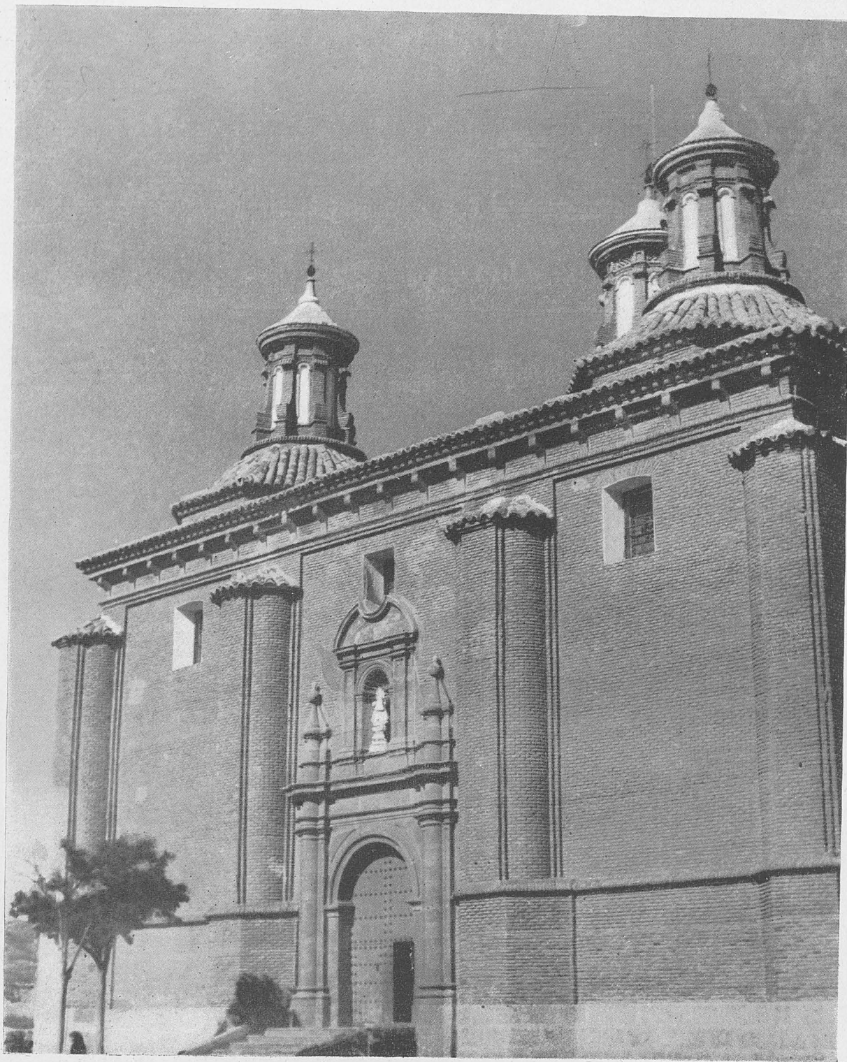
Santuario del Pueyo. Fachada principal.
