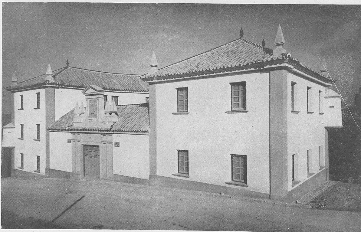
MOCLIN.—Casa Cuartel para la Guardia Civil. Fachada principal.
