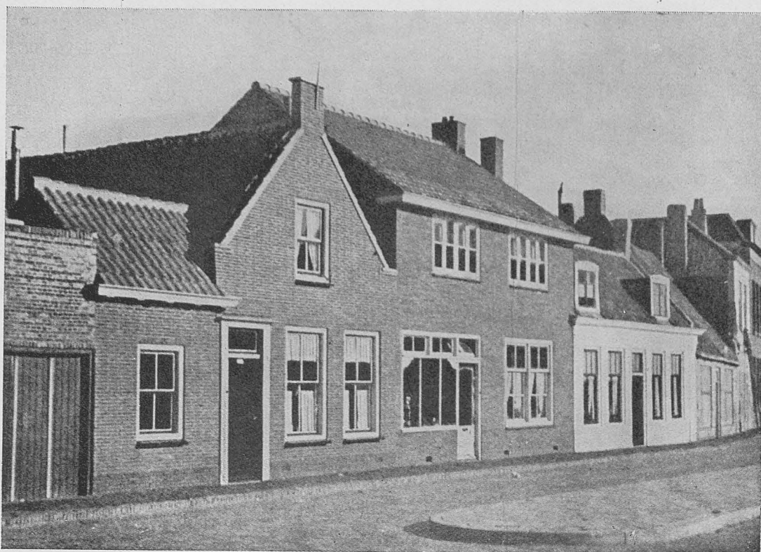
Restauración de casas en Wacheren. 1945-1948.
