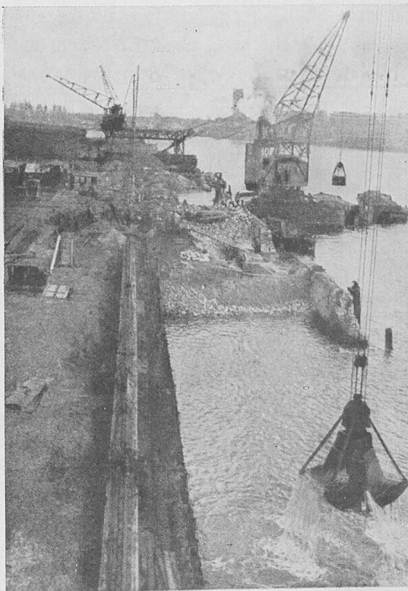
Reparación de los muelles en los puertos.
