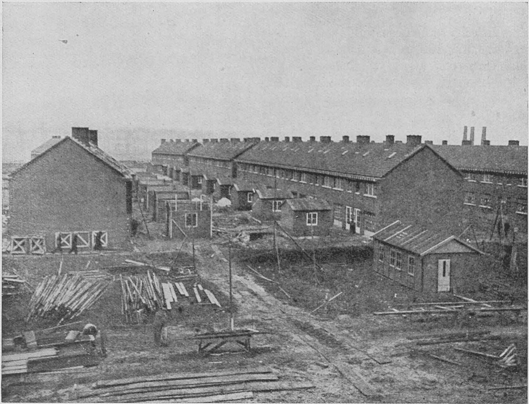
Leyden: casas de obreros en construcción.
