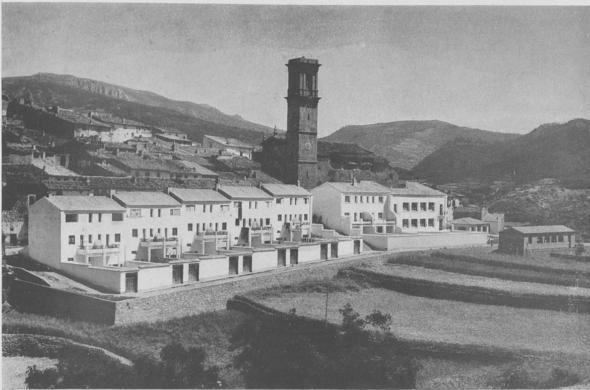
Vista general de Andilla. En primer término: Escuela, casa de maestros y viviendas de labrador.
