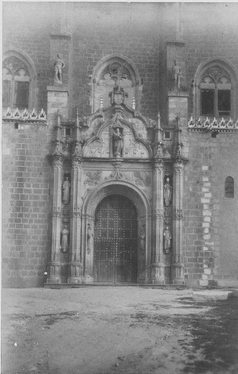
San Juan de los Reyes. Puerta en fachada lateral.
