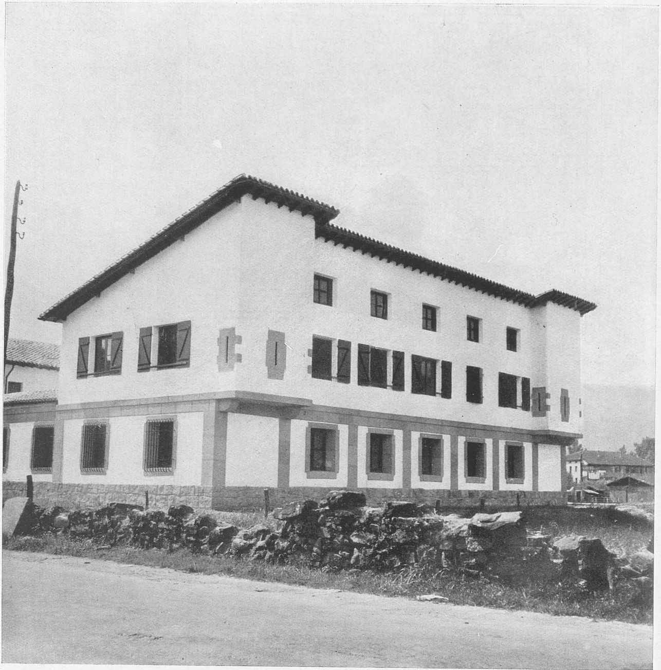
AMOREBIETA.—Casa cuartel para la Guardia Civil. Fachada lateral.
