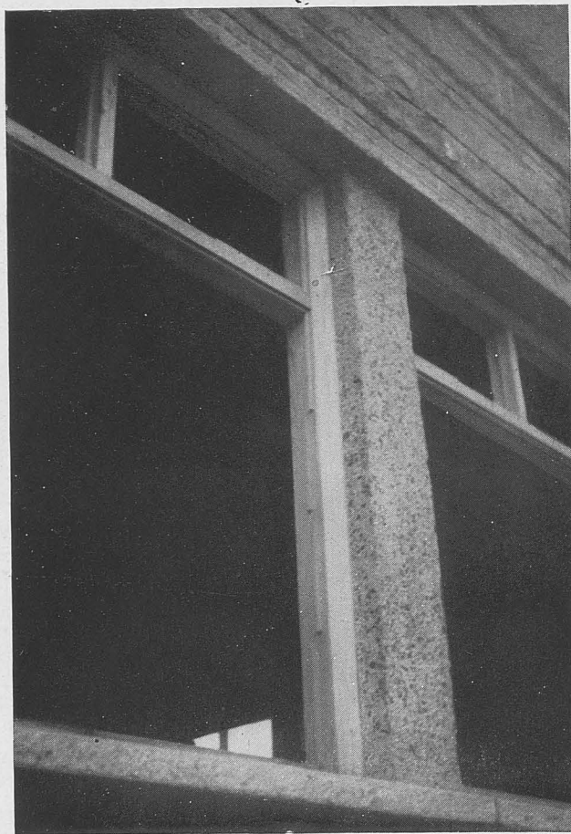
Detalle de la construcción.
