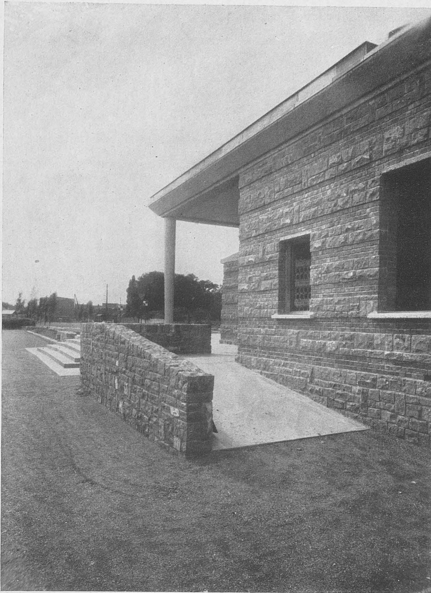
Detalle del porche de entrada.
