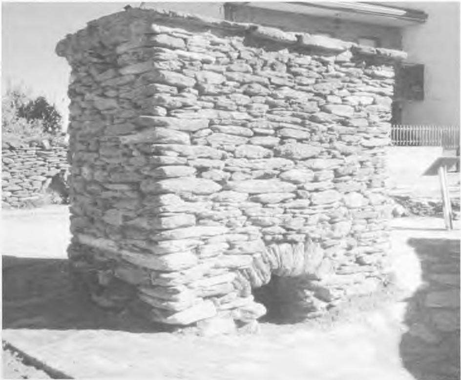
Figura 5. Foto actual del horno alfarero de Zarzuela. Vista frontal del horno en la que se aprecia la abertura por la que era introducida la leña.
