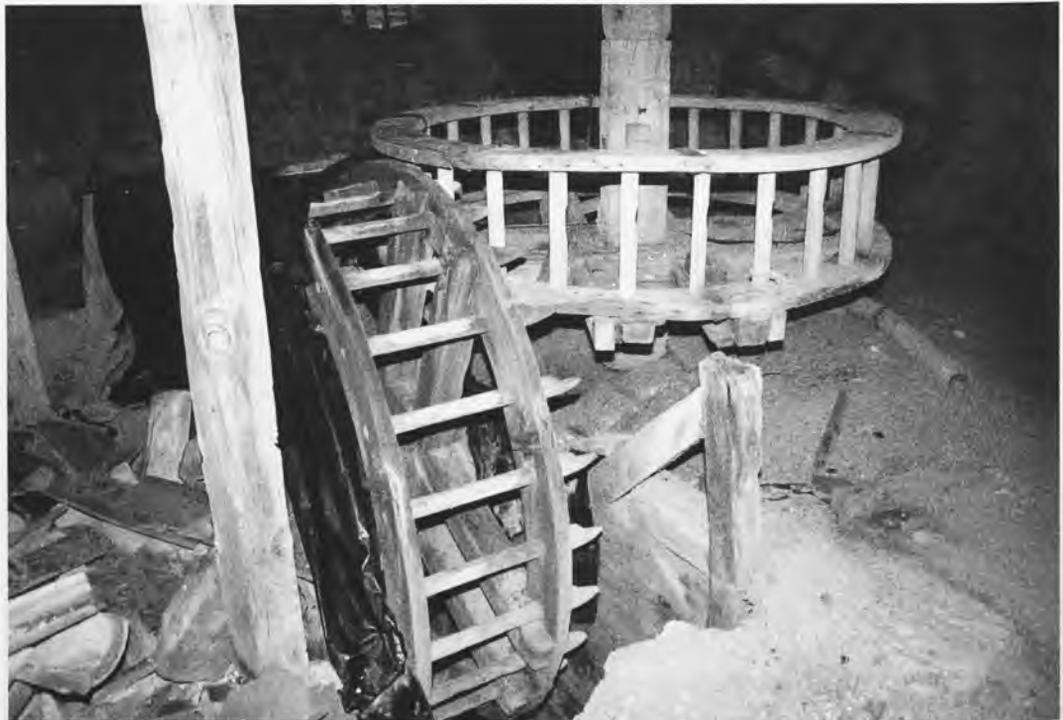
Lám. VII: Noria de las salinas de La Olmeda (Guadalajara). Un aspecto similar debieron de tener las del complejo salinero de Saelices de la Sal. La pieza localizada en la excavación pertenecería al reborde exterior que sujetaba los travesaños del engranaje.
