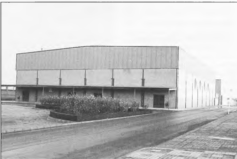
El Ayuntamiento ha destinado 84.000 Euros en la mejora, sobre todo, de la cubierta del Pabellón Cubierto.
