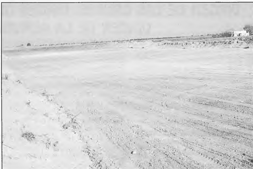
La impresionante imagen del inicio de la construcción de la autovía por Daimiel, que en algunos casos llegará a tener hasta 100 metros de anchura total
