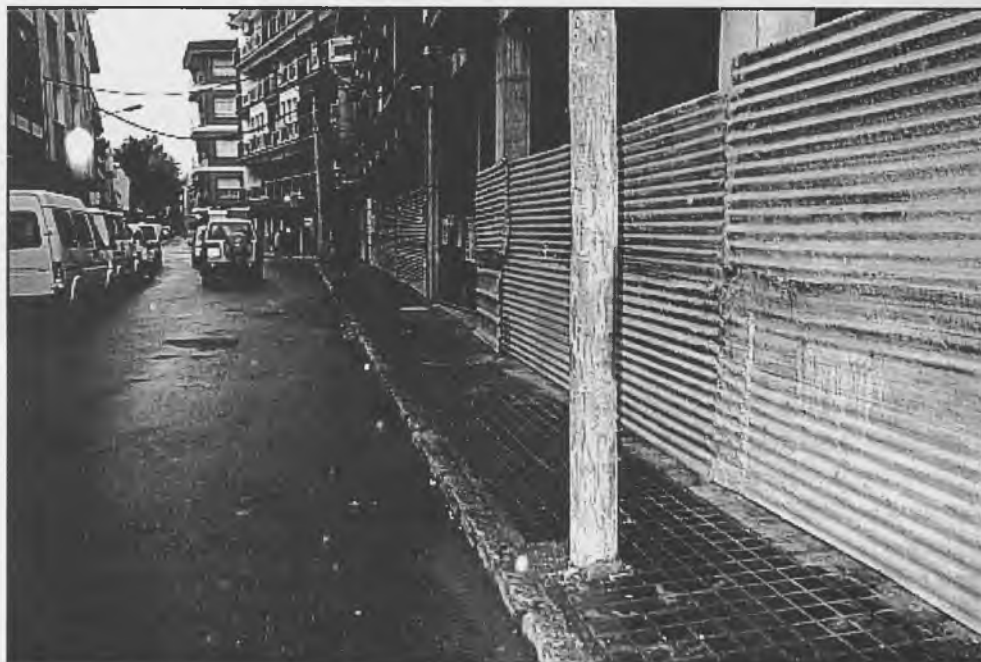
Podemos observar como estos postes de la luz interfieren el paso de los peatones por la acera
