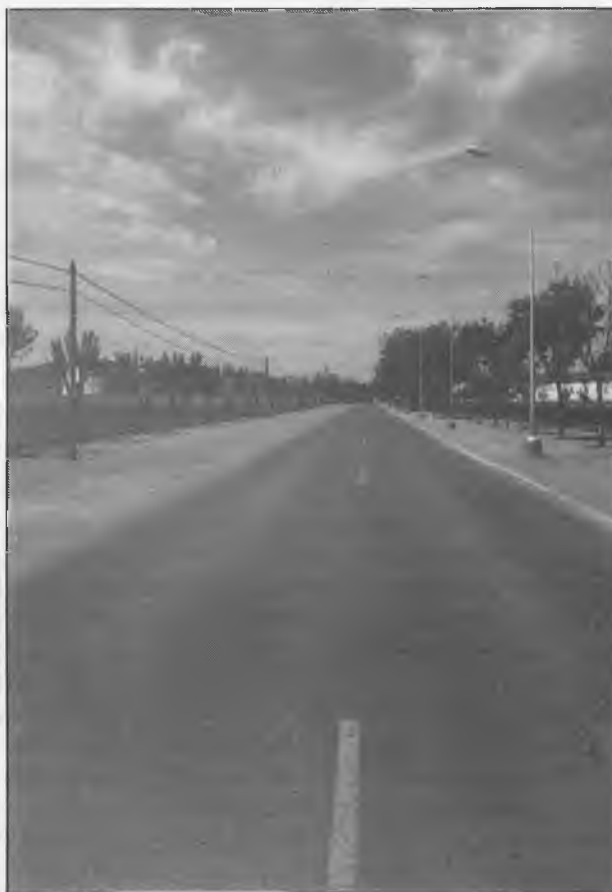
Paseo del Carmen que será acerado por acuerdo municipal
