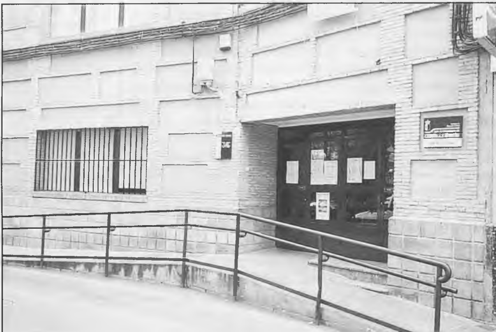
Esperemos que pronto arreglen el ascensor de la Casa de Cultura
