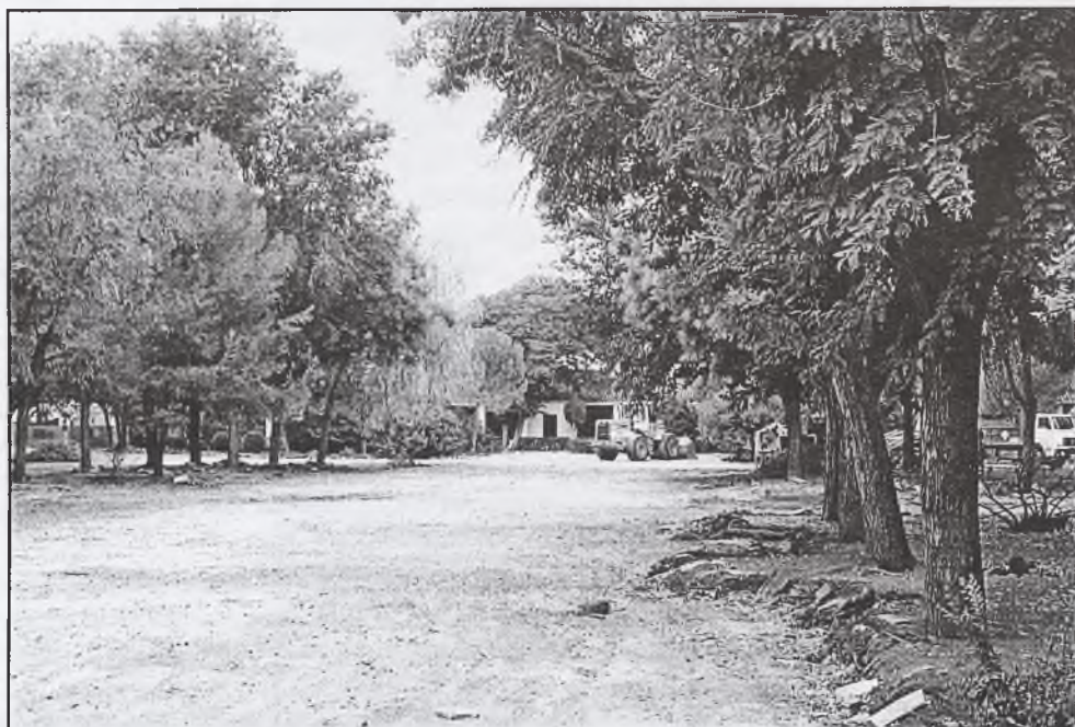
El Parque, en obras
