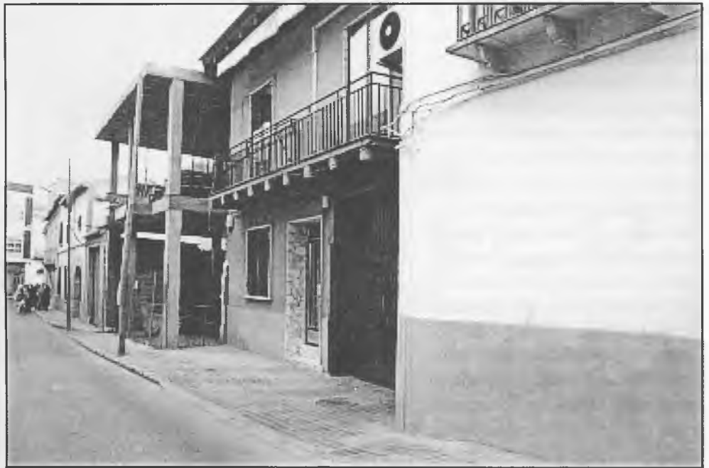
Fachada situada en la calle Quevedo
