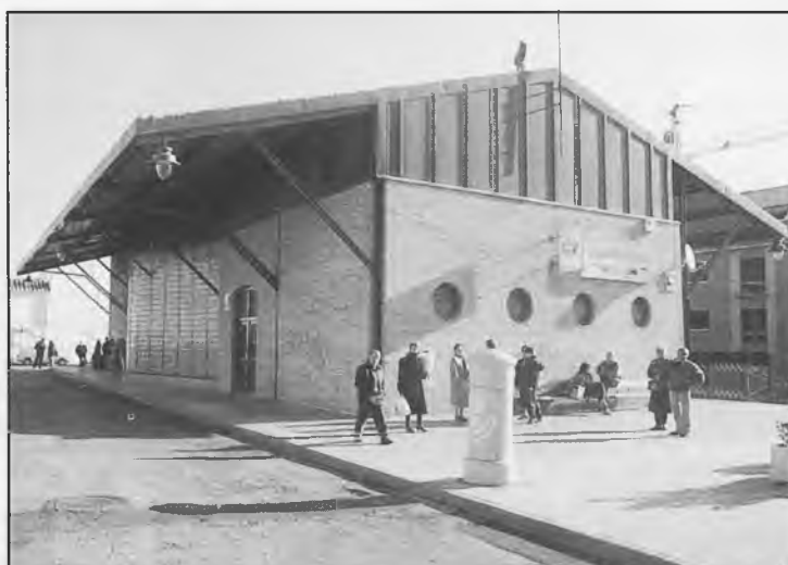
Estación de autobuses
