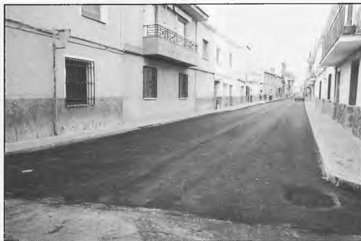
Detalle de la pavimentación de la calle San Roque
