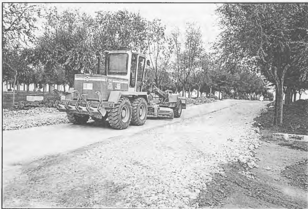
Se está ensanchando y suavizando las curvas del carreterín de Las Cruces
