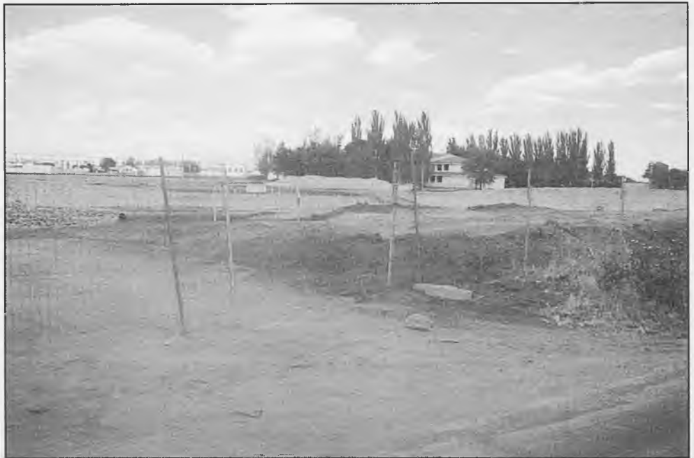
Estado en el que se encuentran las obras del velódromo daimieleño, junto a la Granja Escuela
