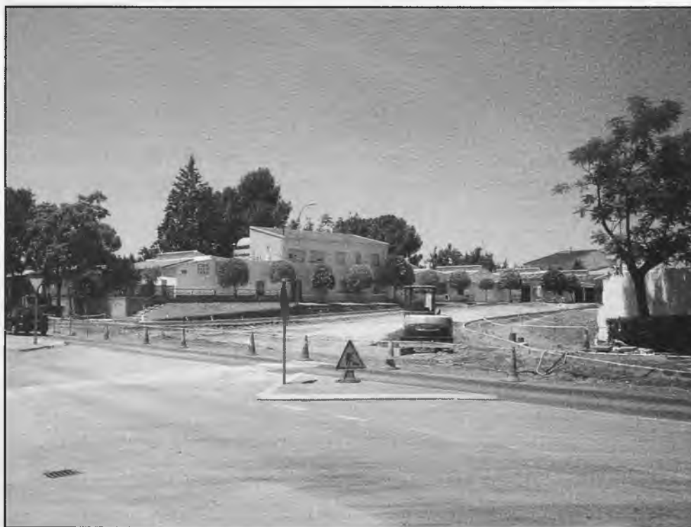
Lugar donde se inicia la avenida de los Deportistas, y ahora se construye la rotonda que unirá ésta con la carretera de salida hacia Madrid.
