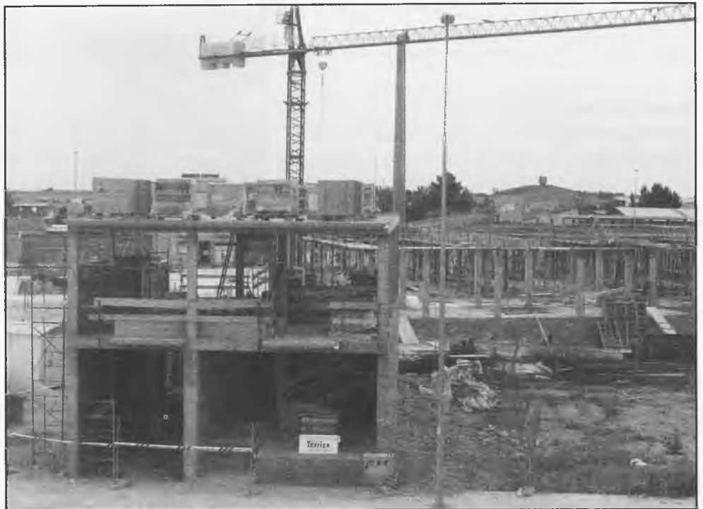
Lugar del trágico accidente del daimieleño fallecido, Manuel Sánchez Valdepeñas, al lado del nuevo Centro de Especialidades, también en construcción.
