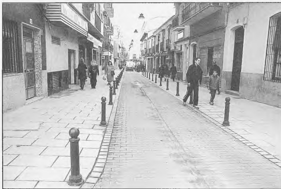
Ya se ha abierto al tráfico la calle Santa Teresa
