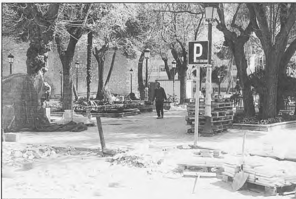
Parterre en obras
