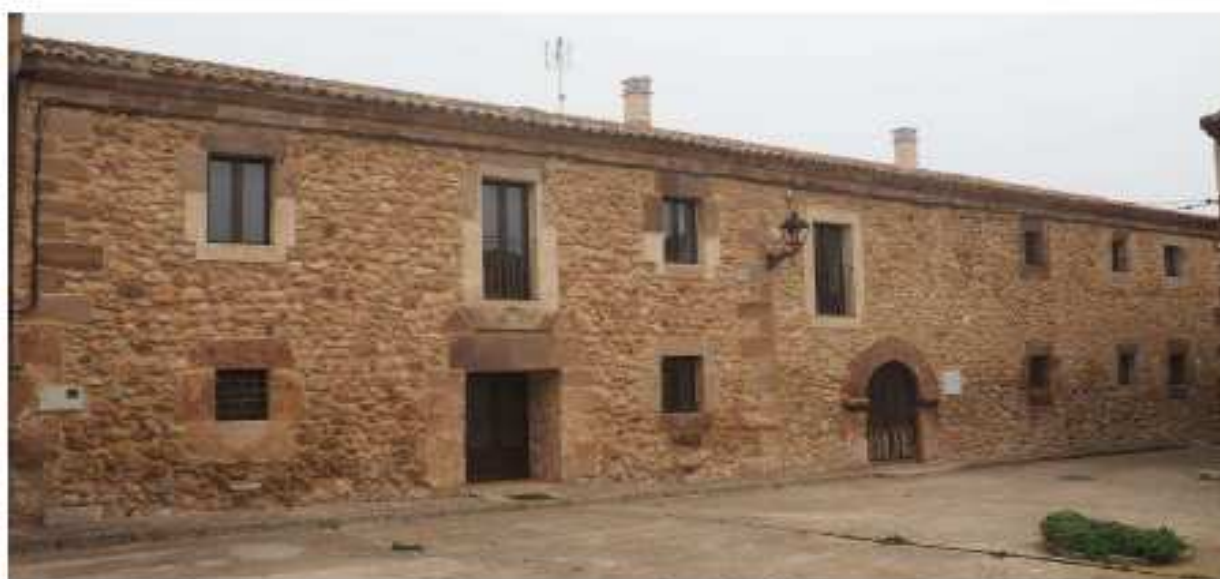
MIEDES: FACHADA DEL PÓSITO (IZDA) Y DEL ANTIGUO AYUNTAMIENTO (DCHA).
