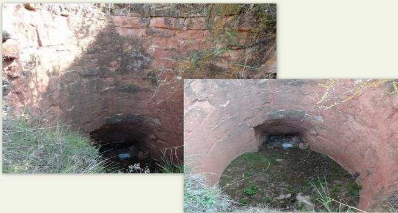
Una auténtica obra de ingeniería: la caída del cubo y bajada a la cárcava o cueva, hoy totalmente obstruida.
