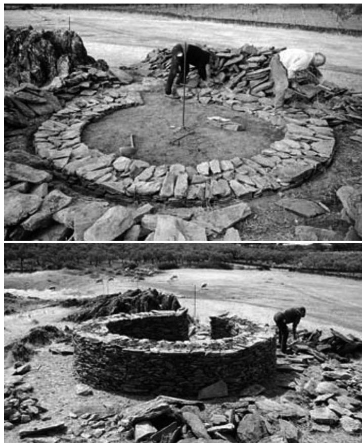
Construcción de un chozo. Fotos Revista Alcántara nº 58
