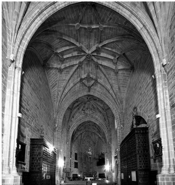
Vista de las bóvedas de la Parroquia de San Andrés
