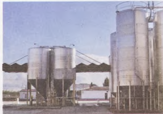
Depósitos y zona de descarga de Vinícola de Tomelloso.
