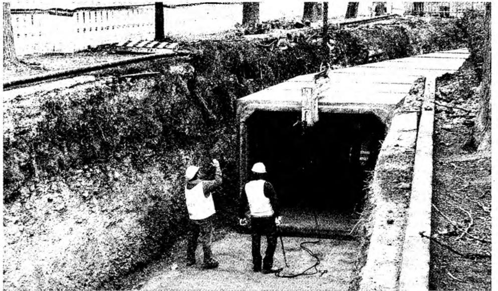
Instalación de marcos prefabricados de hormigón para la nueva canalización.
