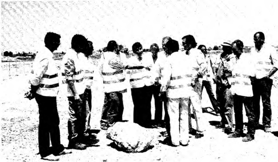
El alcalde, Carlos Cotillas, durante su visita a las obras de la depuradora.
