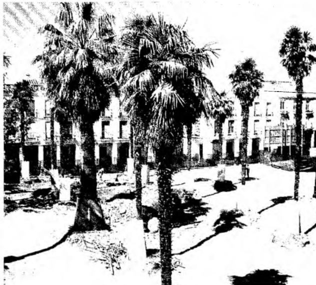
Obras de reforma de la Plaza de la Constitución.
