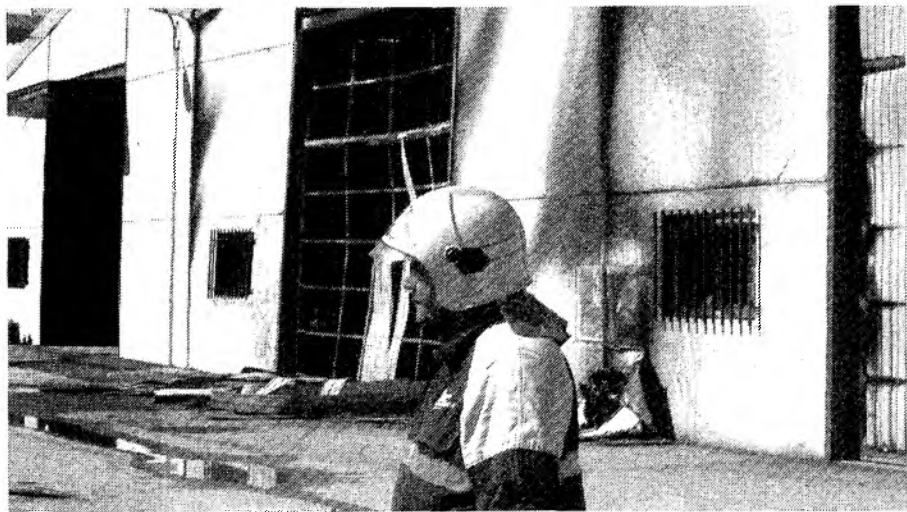
Un bombero a las puertas de las naves incendiadas.
