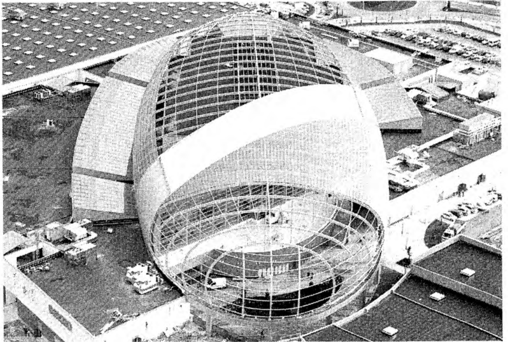
Espectacular cubierta del centro comercial Berceo de Logroño.
