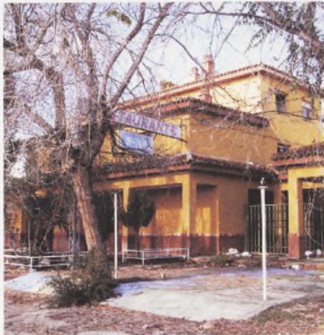
Instalaciones abandonadas del antiguo hotel Cruz.
