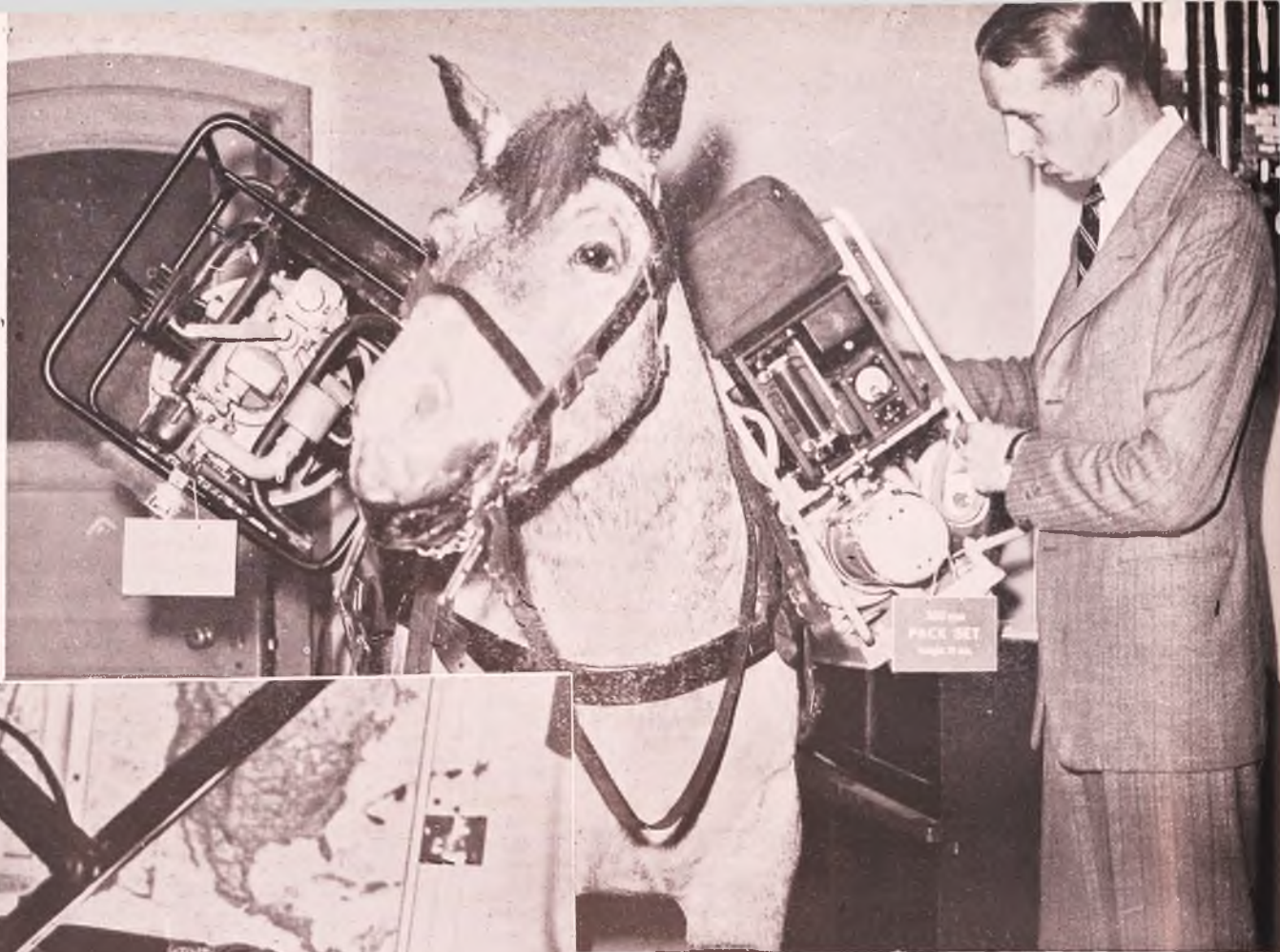
Para hacer posible el montaje de aparatos productores de energía eléctrica en sitios de difícil acceso, una casa inglesa ha construido estos generadores de fácil transporte dado su peso reducido.
