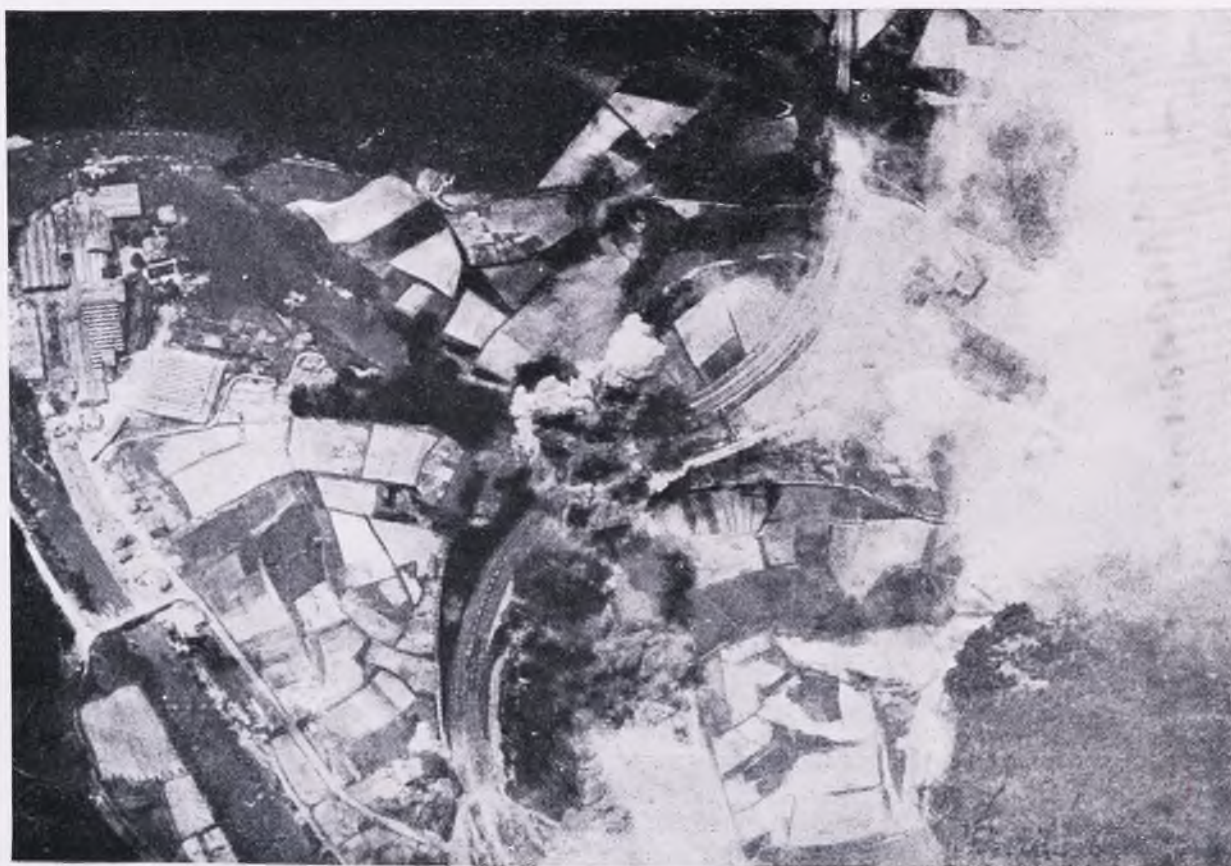
Bombardeo de un nudo ferroviario. Puede apreciarse claramente la exactitud con que está conseguido el objetivo.
