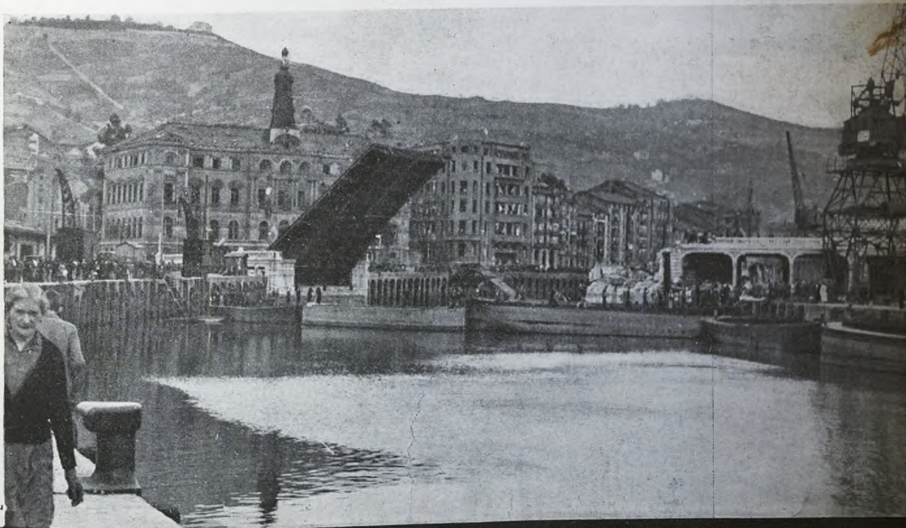
NUEVO PUENTE BASCULANTE
