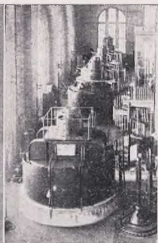
Grupo de generadores de la central hidroeléctrica de Camarasa.
