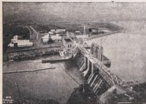
Vista general de la instalación hidroeléctrica de San Lorenzo.
