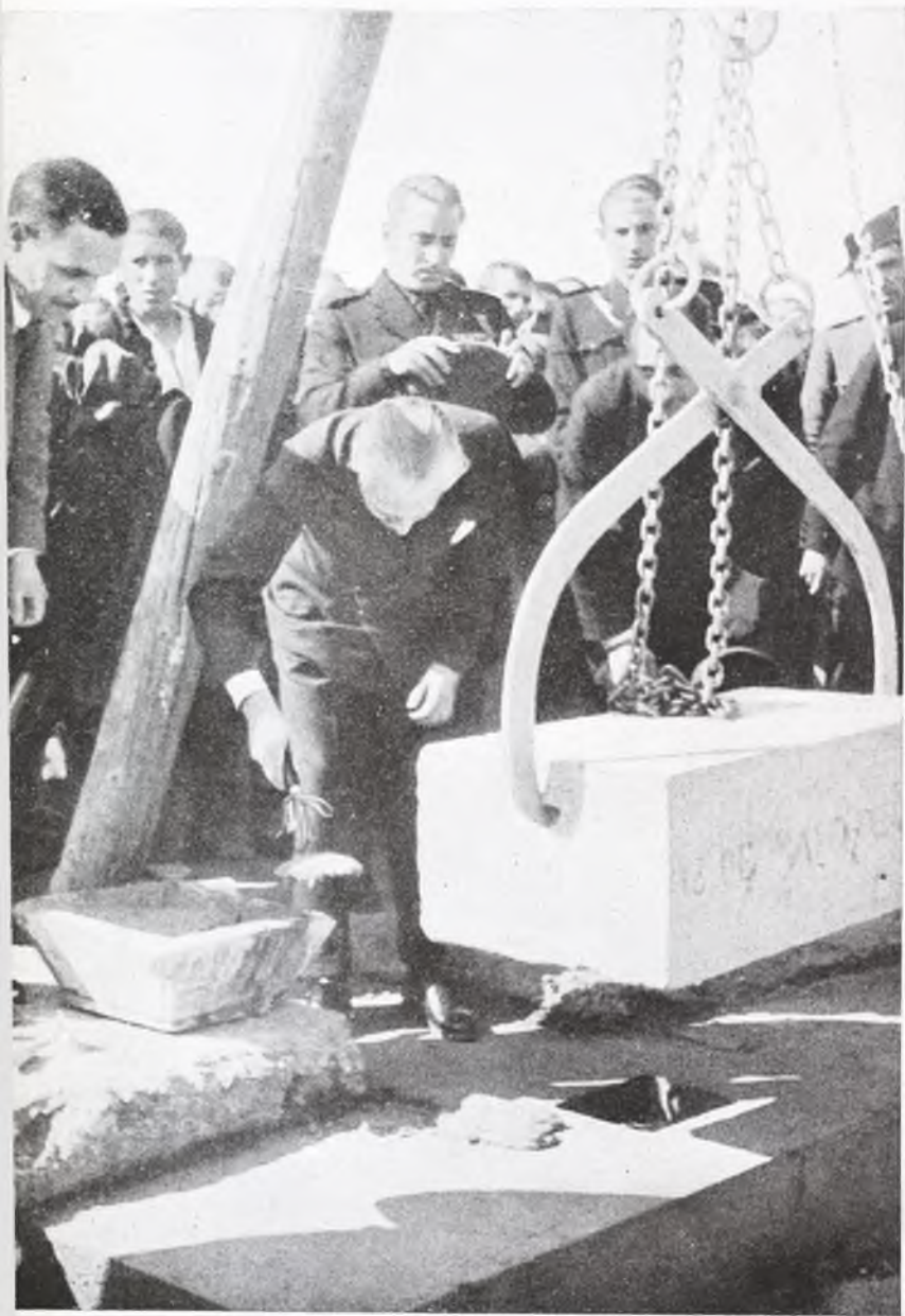
El Presidente de la Junta Política y ministro de la Gobernación, señor Serrano Suñer, coloca la primera piedra de una barriada de casas en Brunete, con la que se inicia la reconstrucción del pueblo. (Foto CIFRA.)
