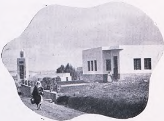
Fachada del nuevo Dispensario en el poblado de Farjana. (Kabila de Masuya)
