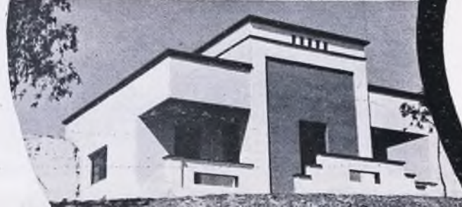
1. a Vista de la Mahcama de Zeluan, recientemente construida.—2. a El Zoko de Dar Driuch (Metalza), cuenta también con esta gran oficina.—3. a Una vista de la Mahcama para autoridades judiciales de Targuist.—4. a Mahcama o edificio para autoridades judiciales de Villa Sanjurjo.—5. a El nuevo Zoko en construcción en Ait Hadifa (Beni Urriague).—6. a Chalet para el servicio de Mejaznias en Isaguen (Llano Amarillo).—7. a Otra Mahcama para autoridades gubernativas en el Zoko Tenin de Beni Buaiach (Beni Urriague).
