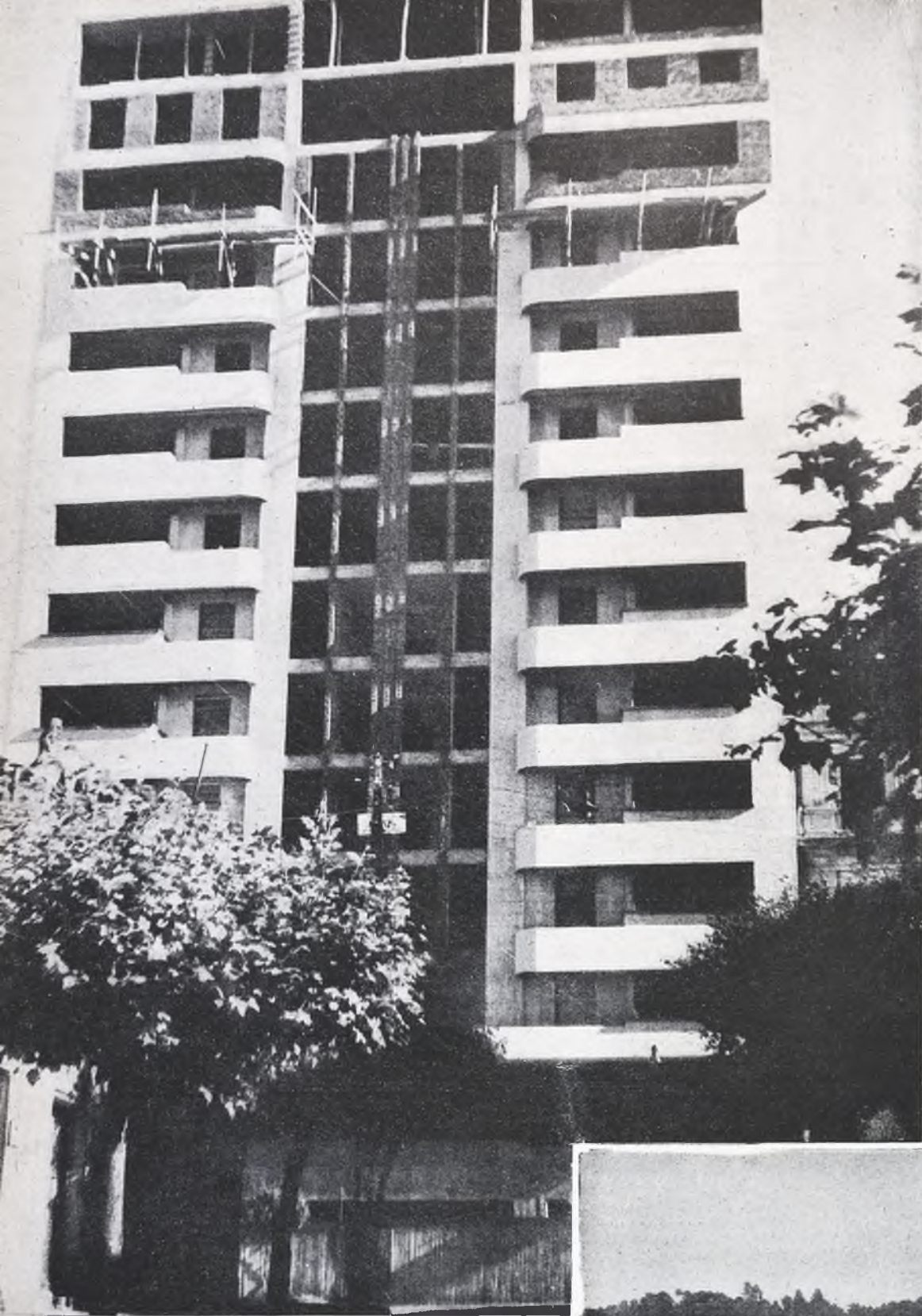
Edificio Herederos de José R. Curbera. En construcción, por CONSTRUCCIONES PERNAS, S. A.
