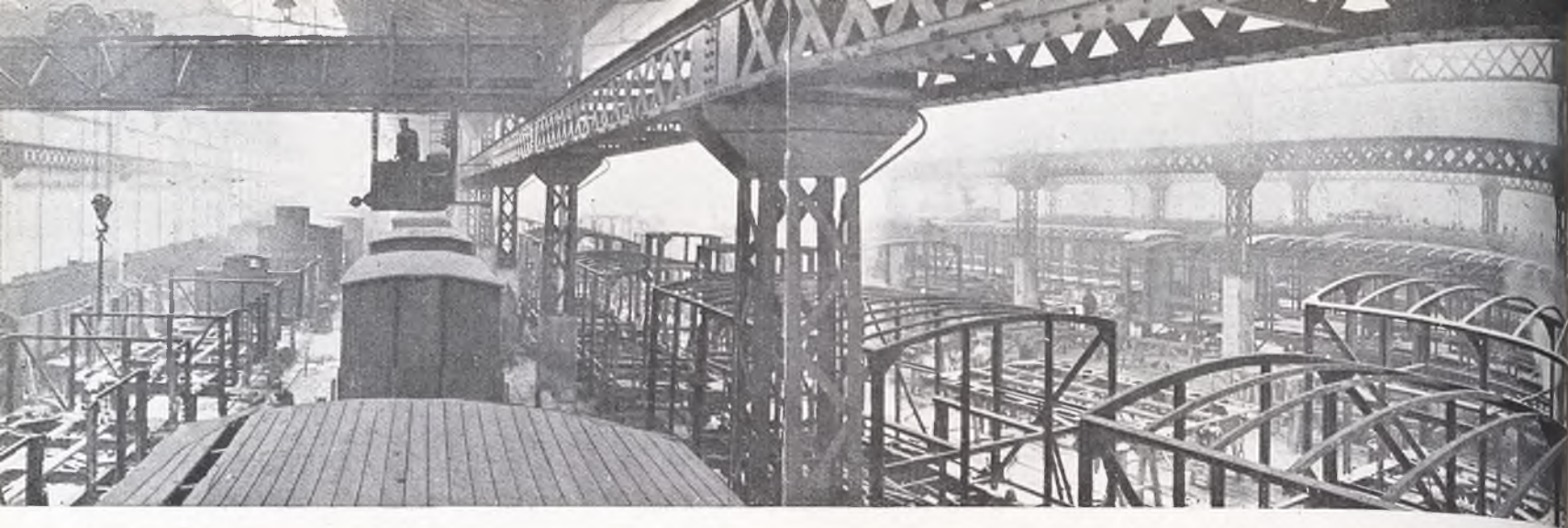
Nave de construcción de vagones (3 y 4).
