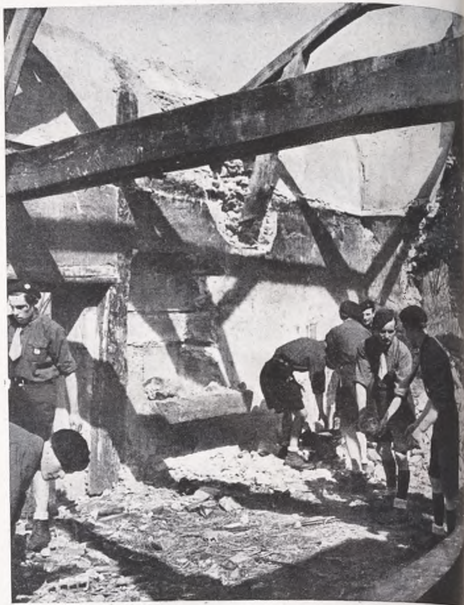
"Los compañeros de Francia" descombran un edificio en ruinas.
