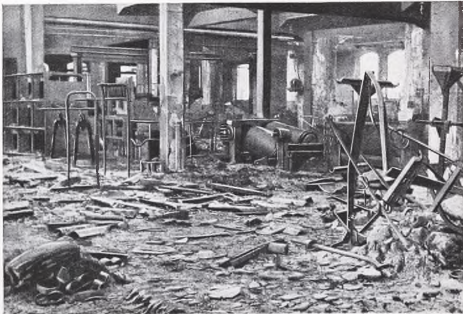
Interior de uno de los pabellones destruidos de la fábrica de Villanueva y Geltrú de PRODUCTOS PIRELLI, S. A.
