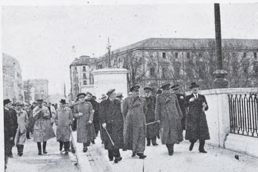
Los ministros de Gobernación y Obras Públicas en el acto inaugural del nuevo Viaducto.
