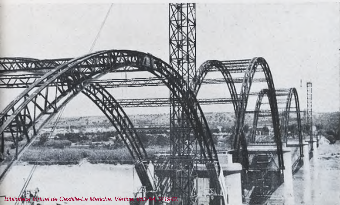
Armadura de un puente sobre el río Ebro, en Mora de Ebro, construida en unos talleres de Barcelona.
