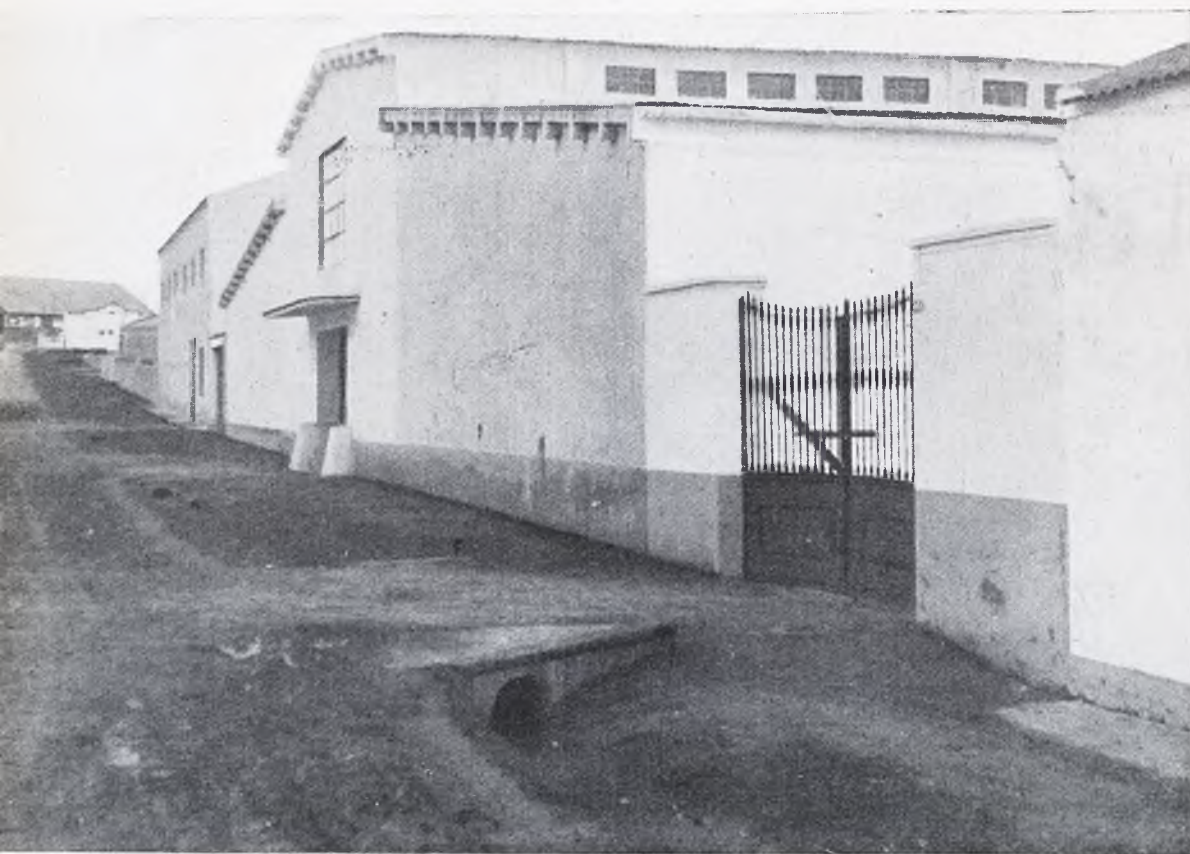
Almacenes de la Caja Rural.—Fachada lateral.
