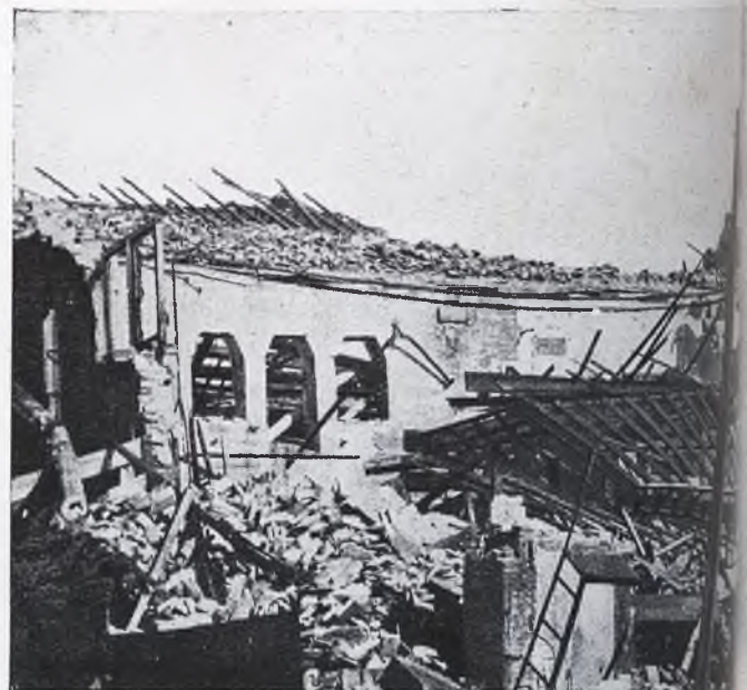
Vista parcial de la fábrica destruida.
