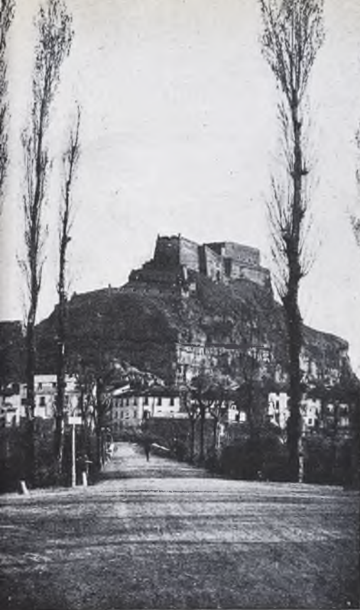
Entrada por el Puente Nuevo.
