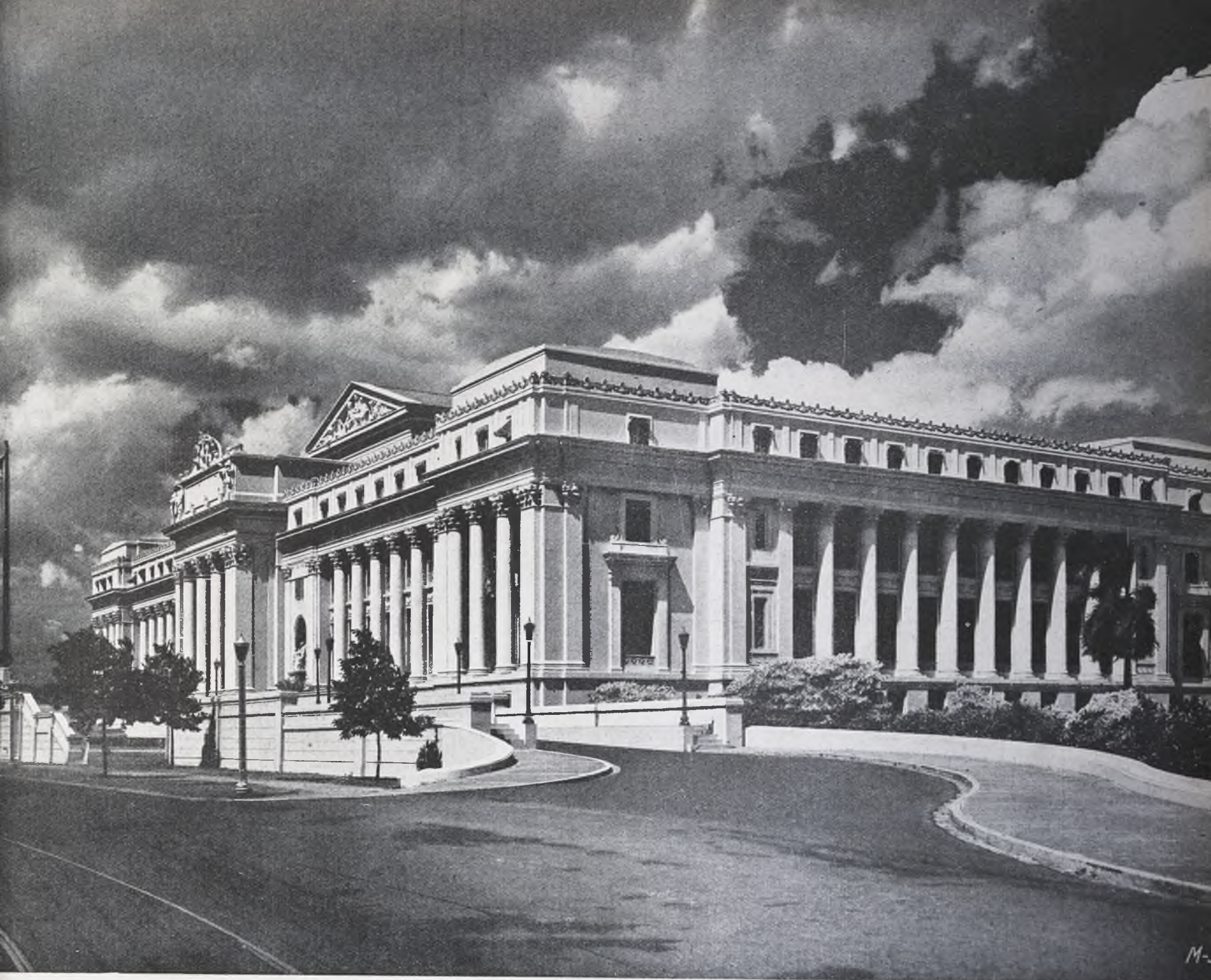
Una perspectiva del magnífico edificio.
