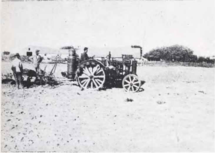
Gasógeno "Creus" montado en un tractor en el año 1919, prueba fehaciente de los desvelos de un inventor español.—Nicolás María Rivero, 9. MADRID.
