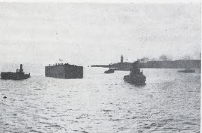
1, 2, 3, 4, 5 y 6. Muelles de Barcelona, antes y después de la reconstrucción.—7 y 8. Transporte de cajones de hormigón armado para el puerto y el dique de Tarifa.
