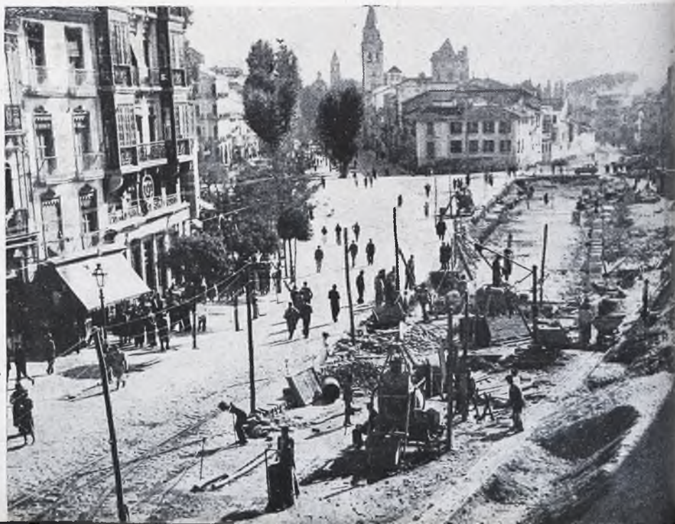
Vista general del embovedado durante la ejecución del segundo tramo de bóveda.
