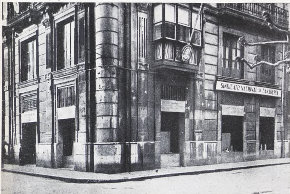
Edificio donde se hallan situadas las oficinas del SINDICATO PROVINCIAL DE GANADERIA Hernán Cortés, 9.
