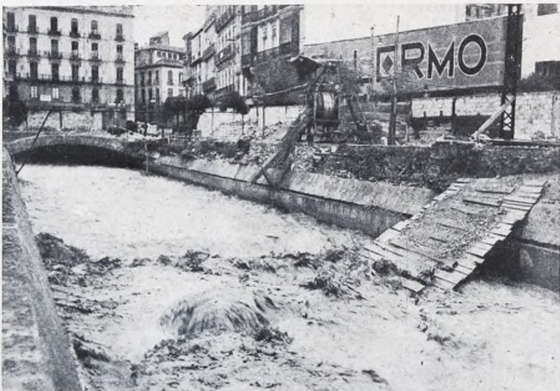
El primer tramo de bóveda al ser descubierta y antes de efectuarse la desviación de las aguas.
