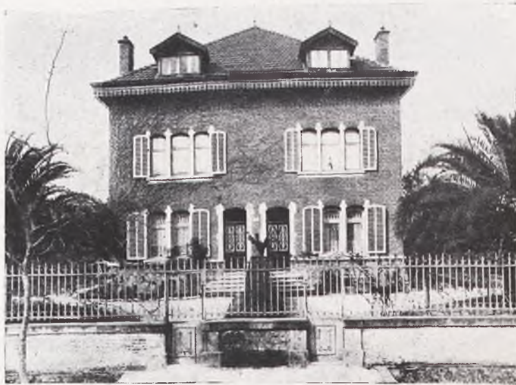
SOLVAY y C. ía - Fábrica de Torrelavega. Tipo de vivienda para el personal
