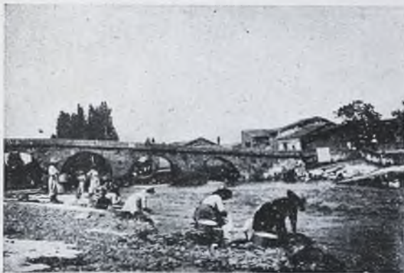
Vista del puente de la Ribera Gata
