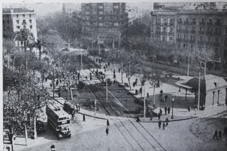
Y otra plaza: la de Urquinaona. El transporte urbano en este lugar parecía un insoluble problema. Y la plaza de Urquinaona, que tenía todo el aire de un oasis abandonado, de golpe y porrazo, merced al esfuerzo de la Compañía y del Municipio, se nos ofrece hoy con toda la gracia de un lugar de reposo.
