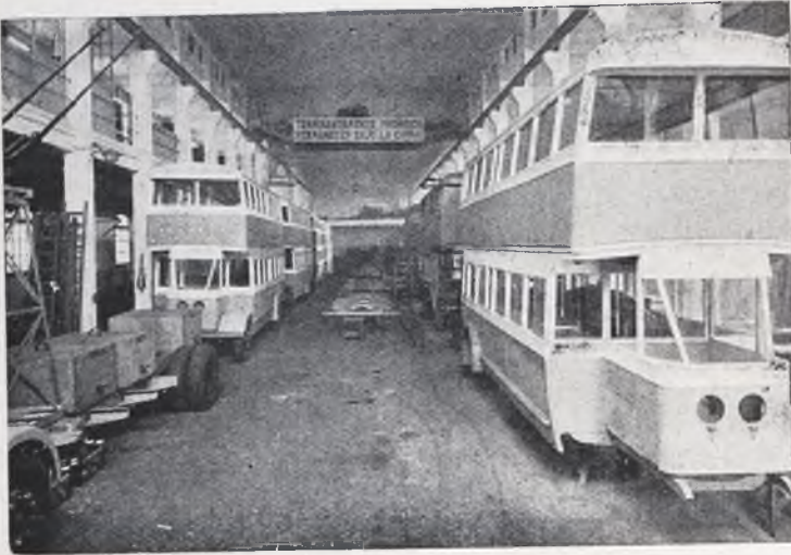
Del esfuerzo realizado para lograr tan amplios resultados en la reorganización del transporte barcelonés, dará una leve idea el hecho de que, en muy poco más de un año, se construyó en Barcelona, con material español y por personal español, todo lo necesario para su instalación. Una vista del taller de montaje de carrocerías.
